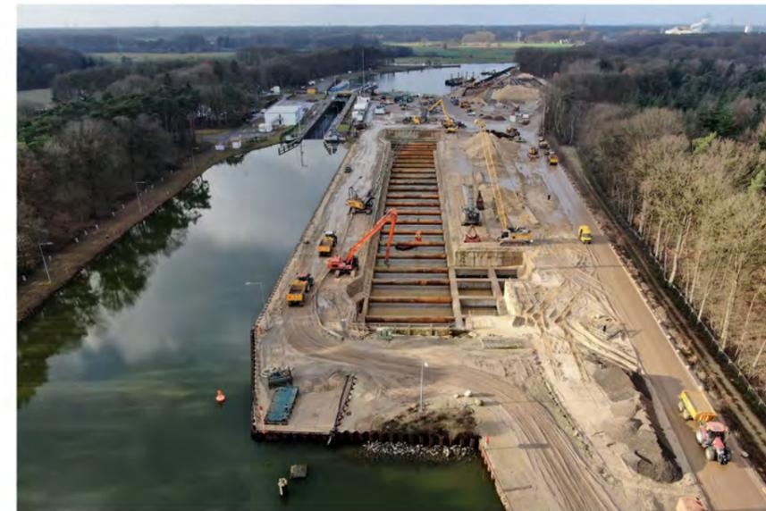
Bild 1: Schleusenbaugrube nach Endaushub
