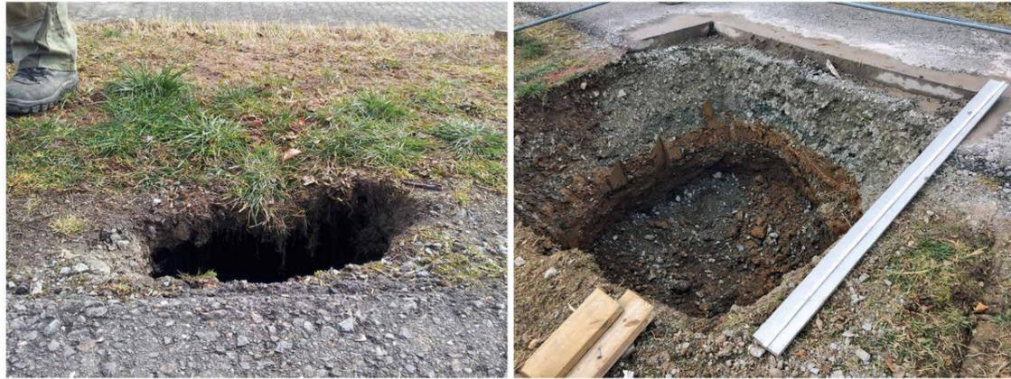
Bild 1: Links: Sichtbare Öffnung an der Geländeoberfläche, rechts: freigelegter Erdfall (Quelle: WSA Neckar)
