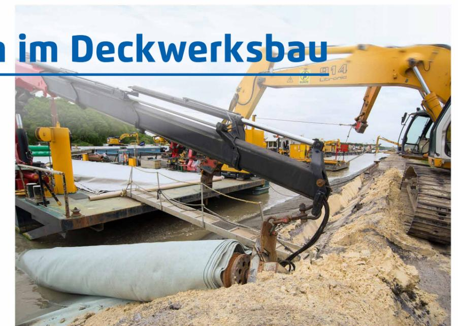
Unter Berücksichtigung der mittlerweile langjährigen Erfahrungen mit dem Einsatz von Geotextilien in Deckwerken und der Anpassung an die technischen Lieferbedingungen für Geotextilien und geotext-
