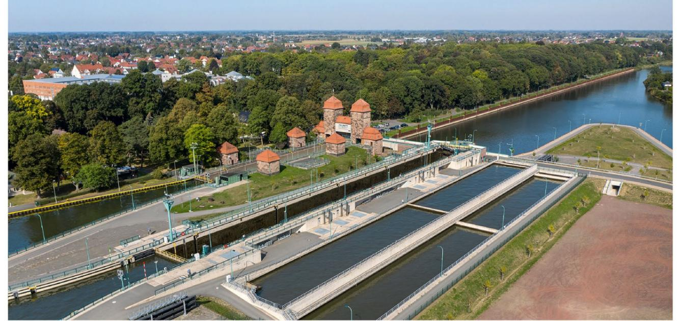
Bild 1: Schachtschleuse Minden (Hintergrund) und neue Weserschleuse inklusive Sparbecken (Vordergrund)
