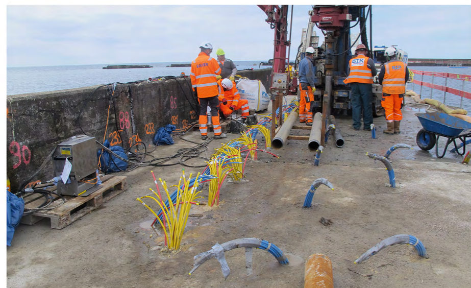
Bild 2: Bohrarbeiten und Injektionsbohrungen mit eingestellten Injektionslanzen
