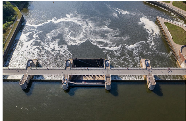
Bild 3: ( n-1 )-Fall durch Umbaumaßnahmen im Wehrfeld (links) und bei gesetzten Revisionsverschlüssen (rechts)
