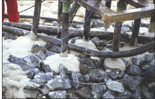
Bild 7: Steinverblockungsverfahren
