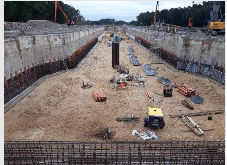
Baustelle: Schleuse Gleesen
