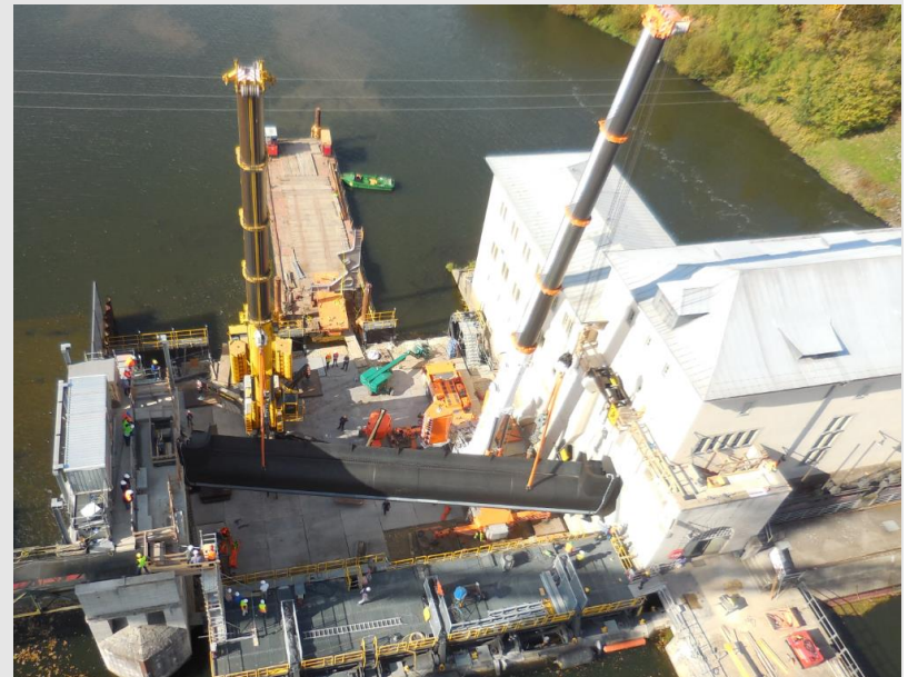
Baustelle: Wehr Viereth
