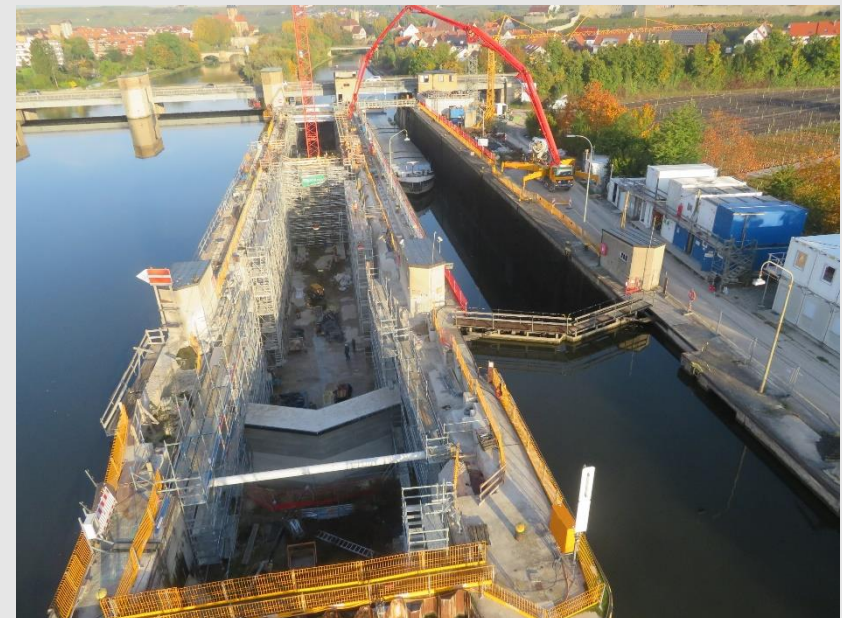
Baustelle: Schleuse Lauffen
