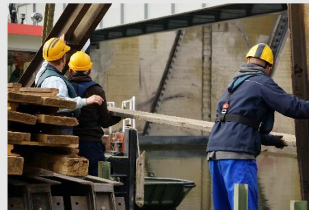
Baustelle: Setzen Revisionsverschluss
