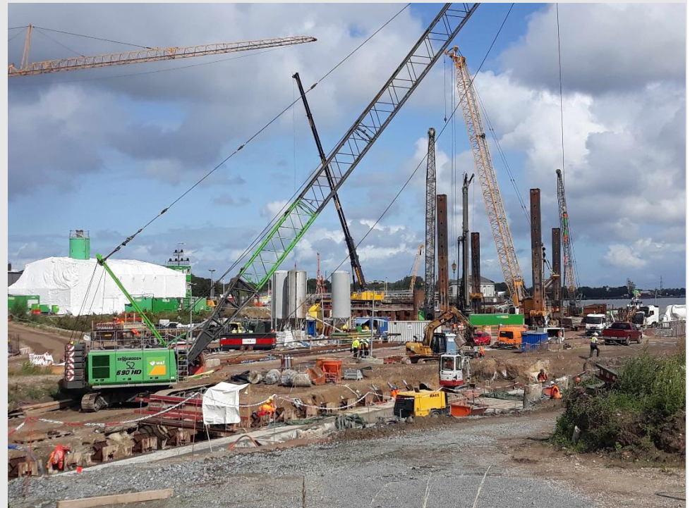
Baustelle: 5. Schleusenammer Brunsbüttel
