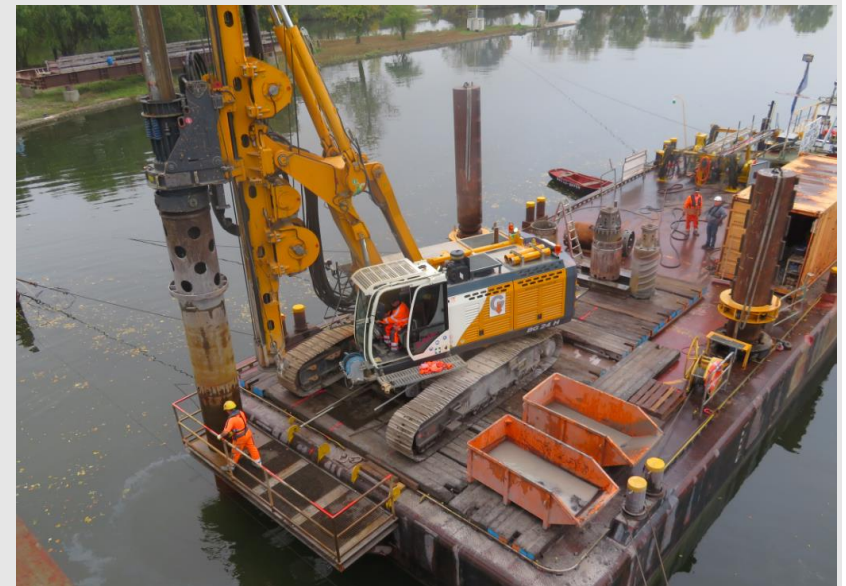
Baustelle: Wehr Horkheim
