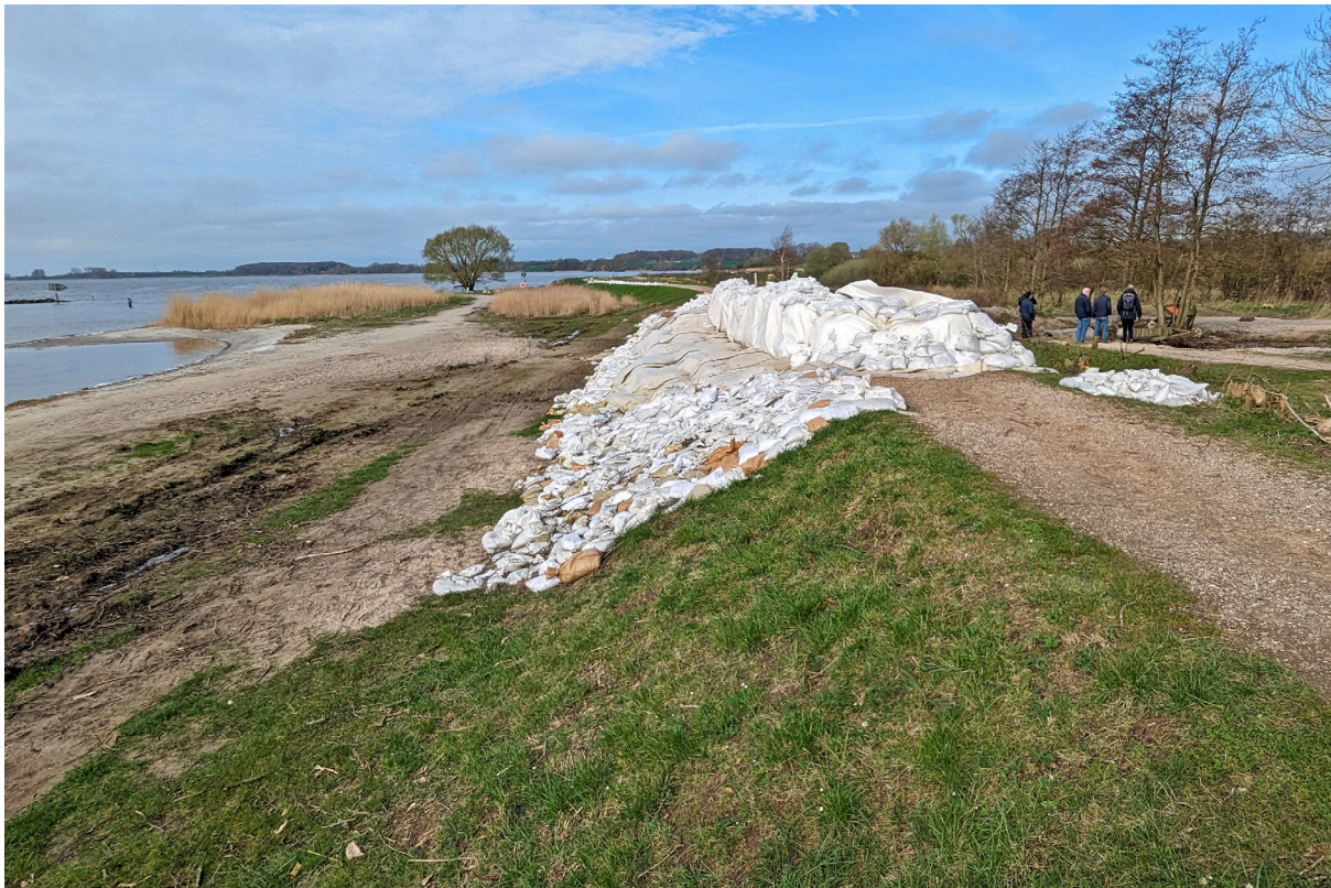
Abbildung 7: Notsicherung der Deichbruchstelle bei Arnis (Foto: J. Hofstede/MEKUN).
