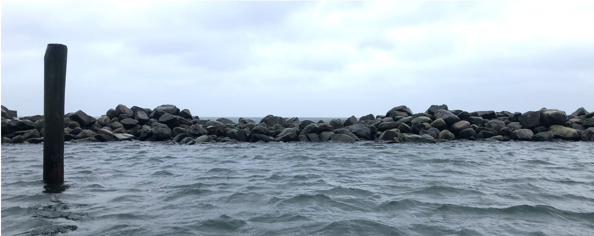
Abbildung 6: Exemplarischer Schadensbereich der Nordmole (Foto: Peters).
