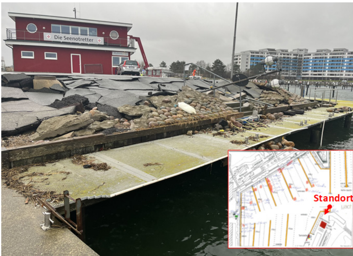
Abbildung 7: Deckwerksschäden im Bereich der DGzRS-Station (Foto: Peters).
