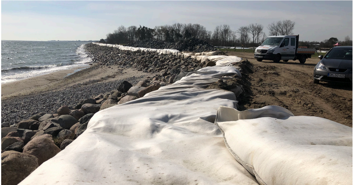
Abbildung 17: Süssau, Geotextilwall, Blickrichtung Süd (Foto: Ramboll, 26.03.2024).
