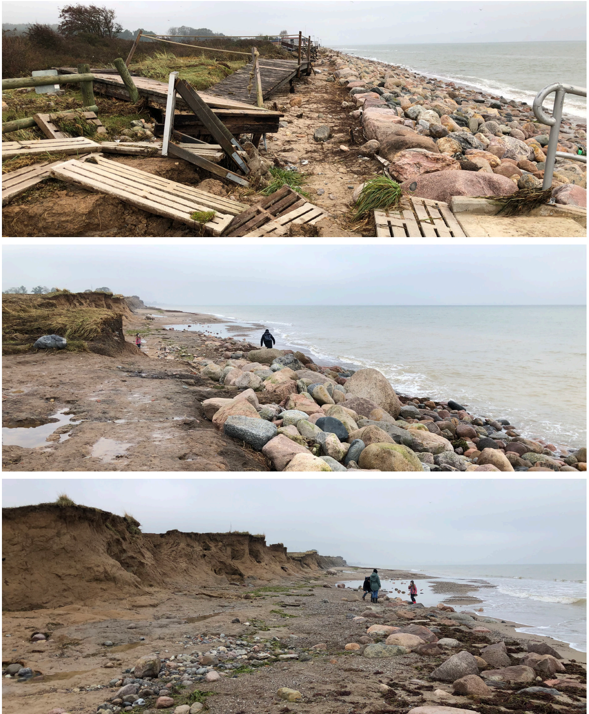
Abbildung 21: Zerstörter Holzbohlenweg (oben), nördliches Ende des Deckwerkes in Süssau (Mitte) mit angrenzendem Kliff (unten) (Foto: Ramboll, 25.10.2023).
