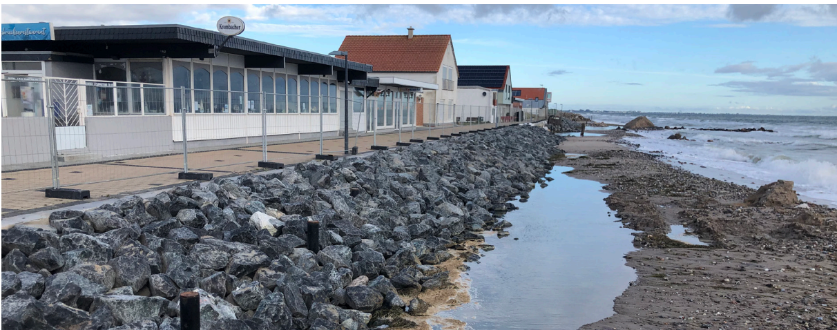
Abbildung 20: Promenade und nördlicher Strandbereich in Süssau mit neuem Deckwerk nach Wiederherstellung (Foto: Ramboll, 02.10.2024).
