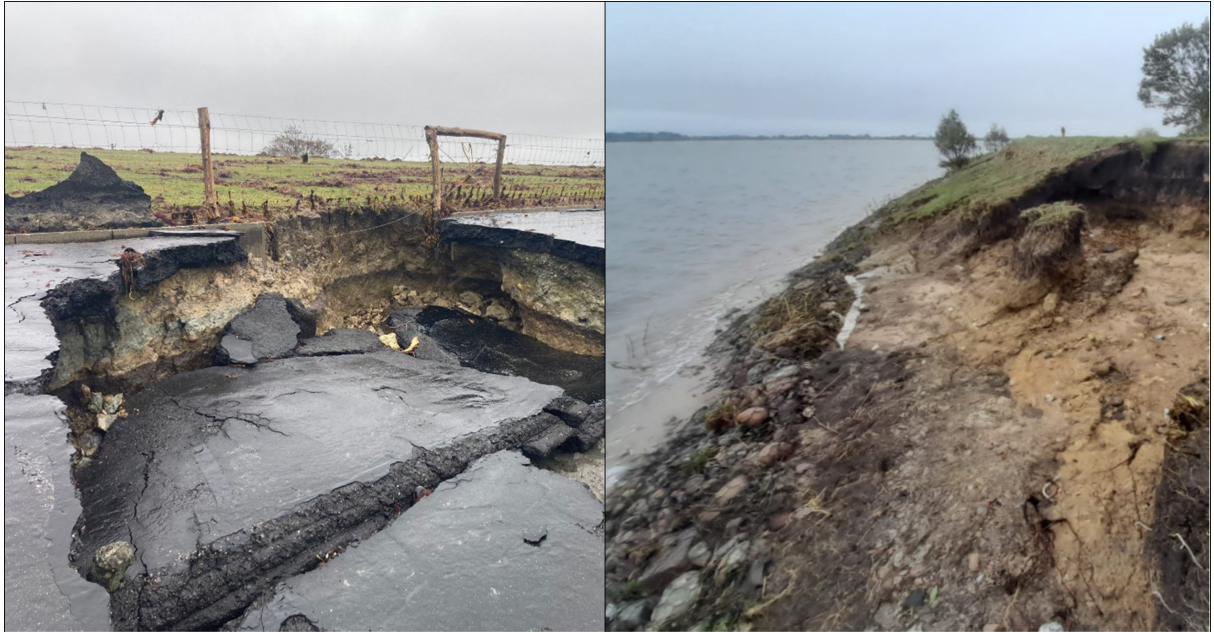
Abbildung 3: Schäden am Asphaltdeckwerk des Landesschutzdeiches Presen (linkes Foto) und an der Außenböschung des Landesschutzdeiches Burg (rechtes Foto) auf Fehmarn (Foto: LKN.SH).
