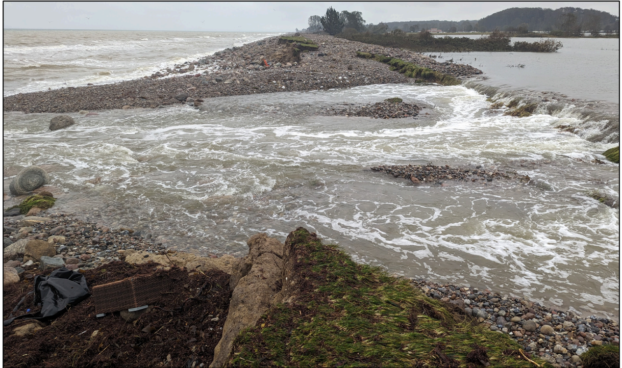
Abbildung 4: Deichbruch im Regionaldeich Fischleger südlich von Damp (Foto: J. Hofstede/MEKUN). Der stark erodierte (grüne) Deich ist fast vollständig durch Geröll überdeckt, was auf eine sehr starke Einwirkung durch brechende Wellen hinweist.
