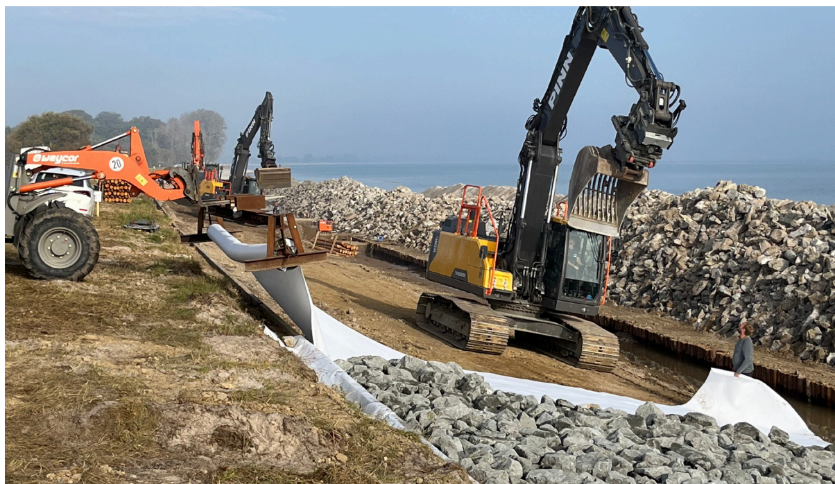
Abbildung 8: Wiederherstellung des Deckwerkes am Regionaldeich Oehe – Ostsee (Foto: H. Skuppin/MEKUN).
