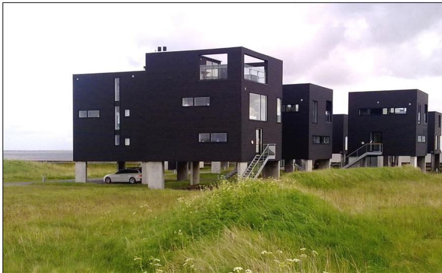
Abbildung 5: „Häuser auf Stelzen“ auf der Insel Røm (DK) als Beispiel für hochwasserangepasstes Bauen in überflutungsgefährdeten Küstenniederungen (MELUND).
