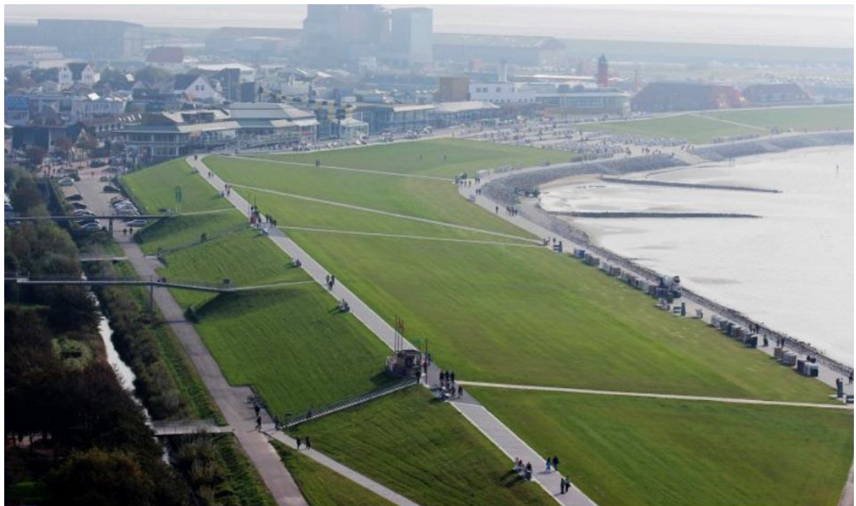
Abbildung 8: Landesschutzdeich in Büsum nach der Verstärkung (© LKN.SH).
