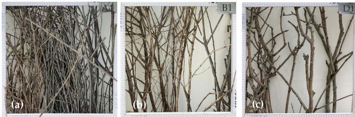
Abbildung 7: (a) Ausschnitt des Sandfangzauns auf Norderney mit 5 bb/m, (b) 3–4 bb/m und (c) 2 bb/m (verändert nach Eichmanns und Schüttrumpf (2021)). Diese Abbildung ist eine open-access Abbildung veröffentlicht unter den Allgemeinen Geschäftsbedingungen der Creative Commons Attribution Lizenz (CC BY) ( http://creativecommons.org/licenses/by/4.0/ ).
