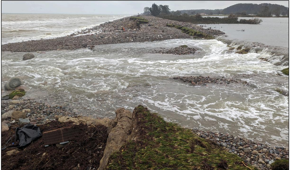
Abbildung 4: Deichbruch im Regionaldeich Fischleger südlich von Damp (Foto: J. Hofstede/MEKUN). Der stark erodierte (grüne) Deich ist fast vollständig durch Geröll überdeckt, was auf eine sehr starke Einwirkung durch brechende Wellen hinweist.
