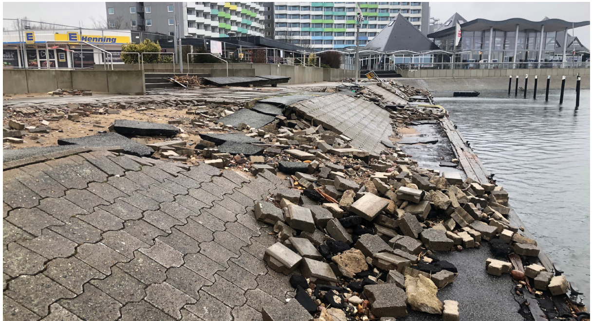
Abbildung 12: Westliche Uferkonstruktion mit schiffsbedingten Schäden an der Hafeninfrastruktur (Foto: Peters).
