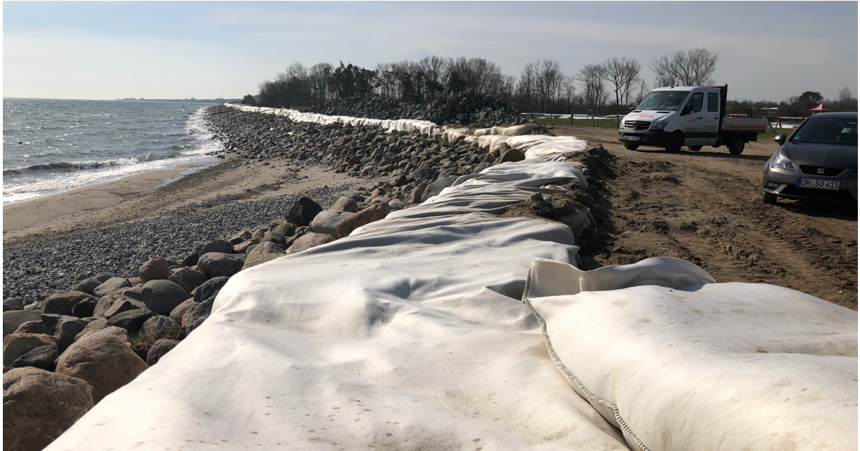
Abbildung 17: Süssau, Geotextilwall, Blickrichtung Süd (Foto: Ramboll, 26.03.2024).
