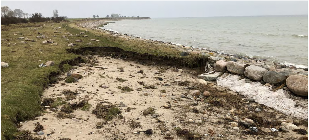
Abbildung 7: Großenbrode, Abschnitt Rethwiese, Blickrichtung Nord (Foto: Ramboll).
