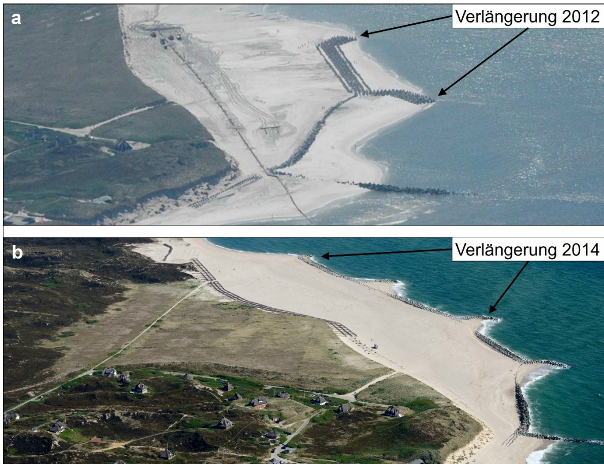
Abbildung 6: Luftbilder von den Verlängerungen des südlichen Tetrapoden-Längswerks im Jahr 2012 (a) und 2014 (b). Luftbilder aus dem Bestand LKN.SH.
