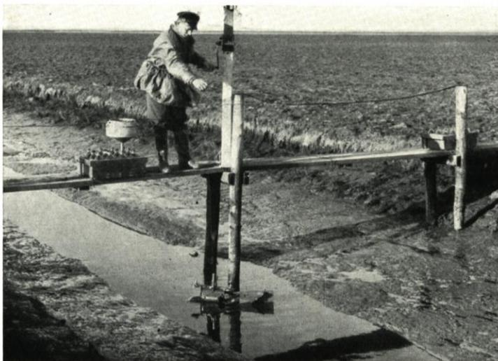
Abb. 9. Sinkstoffentnahme in einer Hauptentwässerung südlich vom Hindenburgdamm
