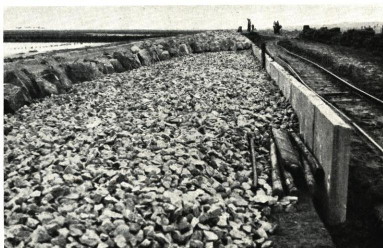
fußes zu vermeiden, wie sie während des letzten Weltkrieges häufig auftrat und zu neuen umfangreichen Fußverstärkungen führte. Eine Reihe Fußpfähle bildet den wattseitigen unteren Abschluß des Deckwerks. Die binnenseitige Verbreiterung der Steindeckenkrone erhält durch eine Betonplatte einen Abschluß gegen die Rasensoden (Abb. 10).
