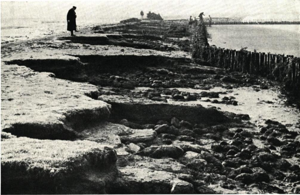
Abb. 4. Einbrüche in das Vorlandufer an der Westseite des Wesselburener Kooges als Folge einer kleinen Sturmflut. Rechts die Schutzlahnung am Fuße der abgeschrägten besetzten Vorlandböschung
