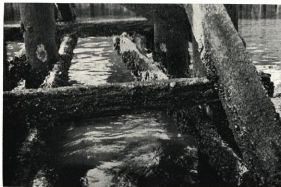
Abb. 19. Rückwärtige Zangenpartie der Seebäderbrücke Cuxhaven, etwa 0,5 m über MTnw
