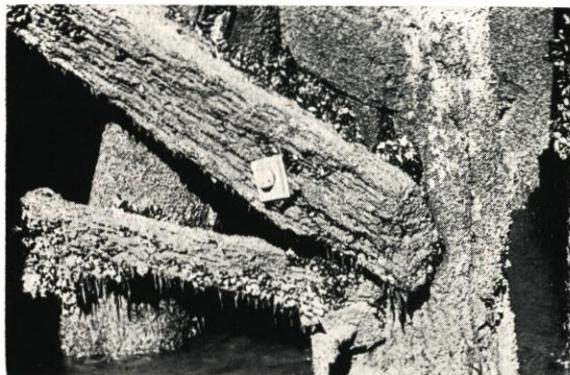
Abb. 17. Zangen von den vorderen Pfählen der Seebäderbrücke in Cuxhaven
