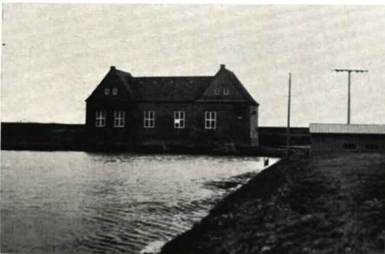
Abb. 10. Das in Bau und Leistung ( $23 \text{ m}^3/\text{s}$ ) 1951 verdoppelte Schöpfwerk Verlath
