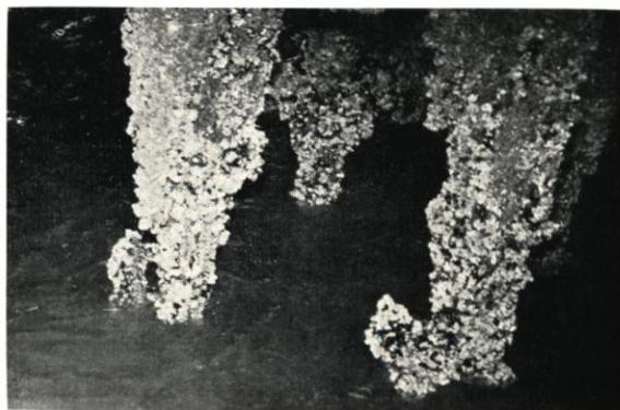
Abb. 21. Zerstörte Pfähle im Steubenhöft, noch eingebaut (1,50 m unter MTnw). Aufnahme bei ungewöhnlichem Niedrigwasser infolge anhaltenden Ostwindes
