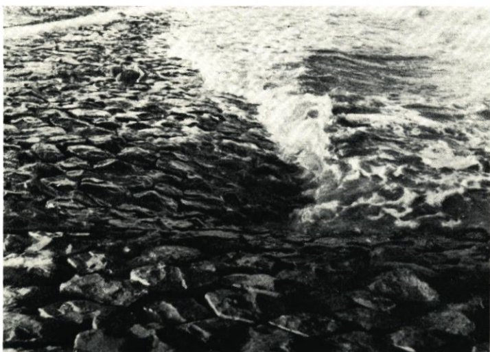
Abb. 10. Das Auflaufen der Wellen am Basaltdeckwerk
