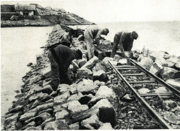
Abb. 12. Bau des Dammes zu dem Fort Brinkamahof
