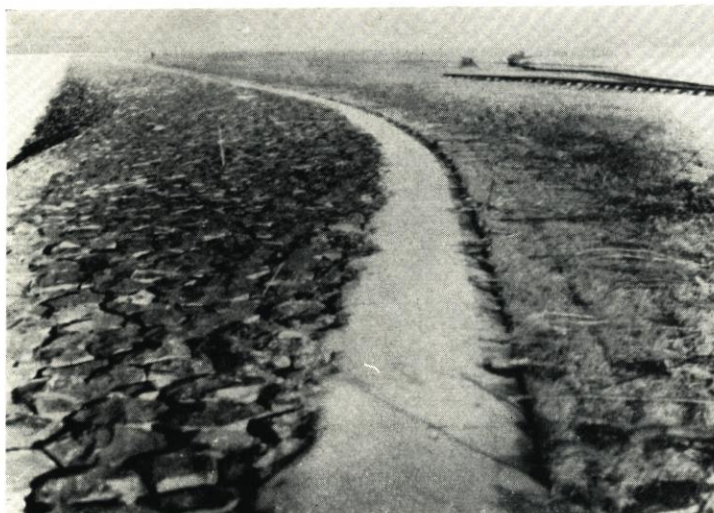
Abb. 8. Das fertige Deckwerk
