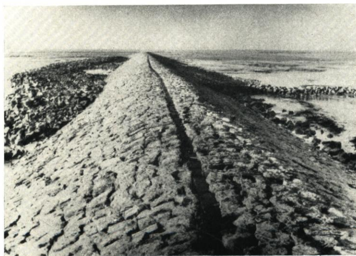
Abb. 18. Die fertige Buhne Solthörn
