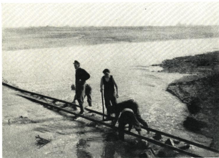
Abb. 16. Beginn der Prielabdämmung
