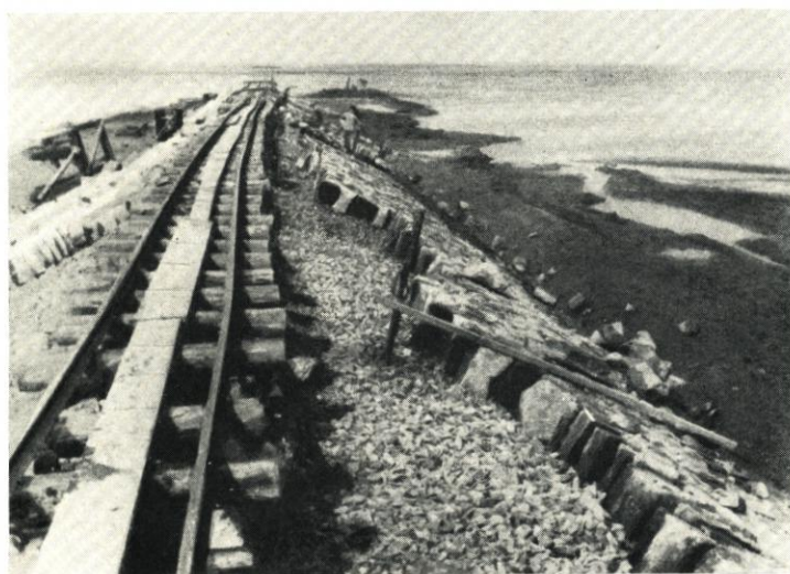
Abb. 17. Die Buhne Solthörn im Bau
