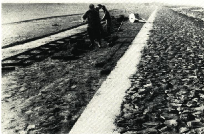
Abb. 9. Andecken der Rasensoden hinter dem fertigen Deckwerk (vgl. Abb. 4)
