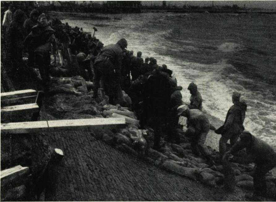
Abb. 9. Sicherungsarbeiten am Seedeich beim Wasserstandsanzeiger in Bremerhaven
