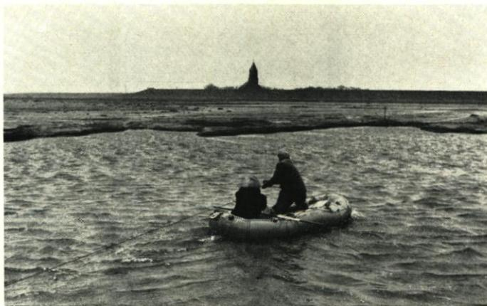
des Wassers sichtbar. Nach dem Trockenfallen des Kooges blieb sie bis zum Rand mit Seewasser gefüllt. Die in diesem Zustand erfolgte Auslotung (Abb. 29) vermittelte eine Vorstellung vom Relief eines von einem Deichbruch herrührenden Kolkes (Abb. 27 bis 29). Die Maße wurden durch Quer- und Längslotung festgestellt und betragen: Länge 65 m, Breite 34 m, Tiefe bis 7 m.
