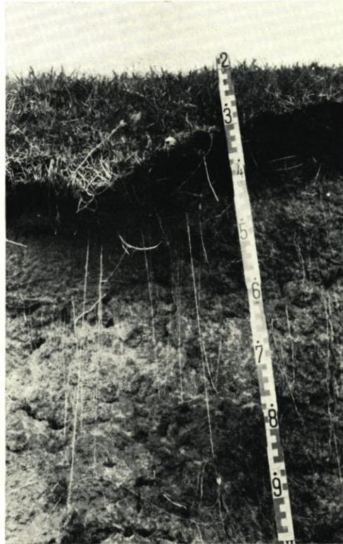
Abb. 6. Die fädigen Wurzeln von *Agropyron littorale* dringen einzeln 2 m tief in den nährstoffarmen sandig-schluffigen Deichkern, aber die Grasnarbe an der Böschung des Deiches ist schlecht und besitzt keine Abwehrkraft gegenüber dem Wasser
