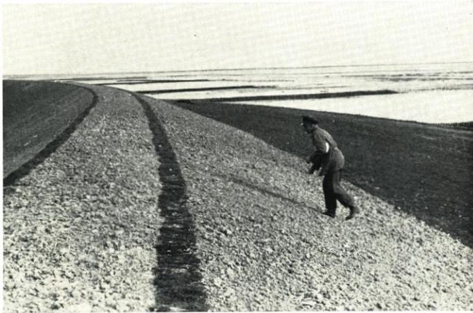
Abb. 23. Der oberste Abschnitt der Außenböschung des neuen Seedeichs, seine Krone und Innenböschung werden mit biologisch abgestimmten Grasgemischen angesät. Wegen der im Laufe des Tages regelmäßig zunehmenden Seewinde erfolgt die Ansaat von Hand in den frühen Morgenstunden. Die Deichkrone wird beiderseits durch Einfügung eines Sodenbandes gegen Formveränderungen bis zum Aufgehen der Ansaat abgesichert
