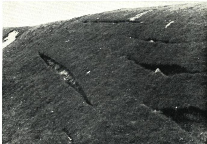
Aber noch immer gibt es Landesschutzdeiche mit sozusagen „antike“ Profil. An solchen Deichen bedarf es zum Beispiel keiner Sturmflut, um die Gefahren einer zu steilen Innenböschung vor Augen zu führen. Die Abbildung 1 zeigt einen Landesschutzdeich, dessen Innenböschung eine Neigung von weniger als 1 : 1,5 hatte. Nach dem Winter 1935 fanden bei normaler Wetterlage umfangreiche Rutschungen in einem Maße statt, daß der Deich durch den Substanzverlust bedrohlich geschwächt wurde.
