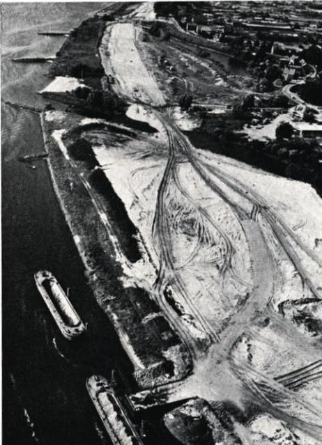
Abb. 8. Spülfeld mit Kleiumschielanlage
