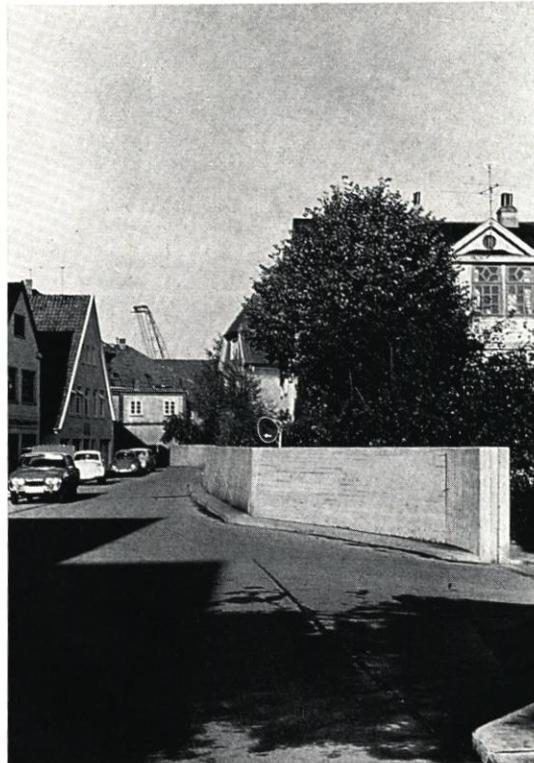
Abb. 4. Deicherhöhung durch Betonmauer mit angehängter Fahrplanplatte im Stadtgebiet Elsfleth, erbaut 1961. Diese Lösung hat sich bei der Sturmflut 1962 bewährt
