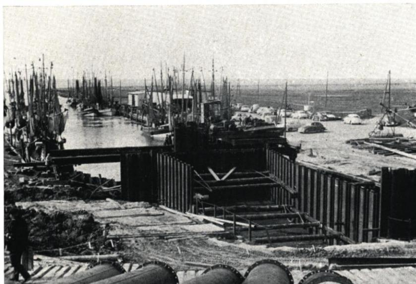
Abb. 8. Verlängerung des Sielbauwerks am Dorumer Tief als Folge der Deichverstärkung 1965
