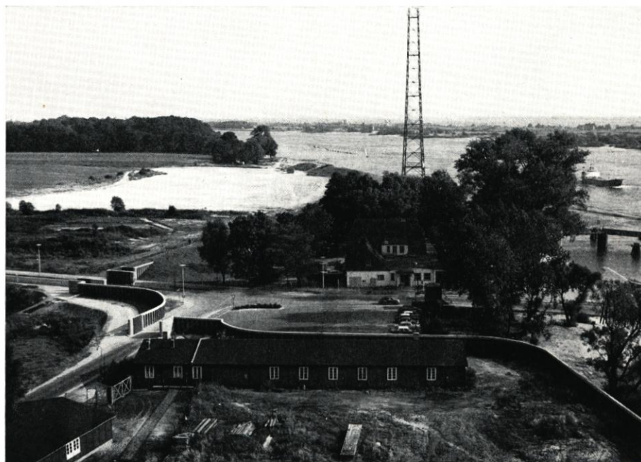
Abb. 4. Die neue Hochwasserschutzanlage beim Kraftwerk Farge in Bremen-Farge
