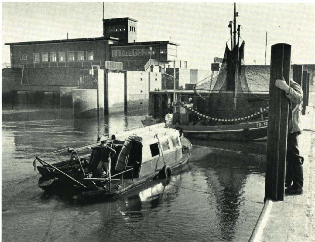
Abb. 8. Aufnahme des Sieles und Schöpfwerkes Harlesiel mit geöffneter Kammerschleuse. Im Vordergrund ein KÖSTERSches Räumboot
