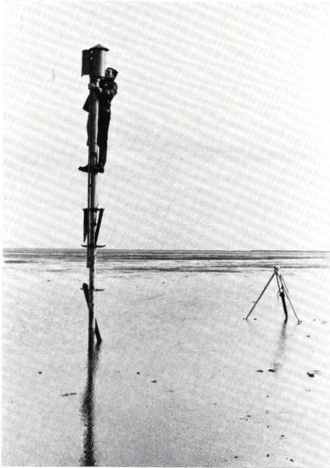
Abb. 8. Betreuung eines Hilfspegels im Watt
