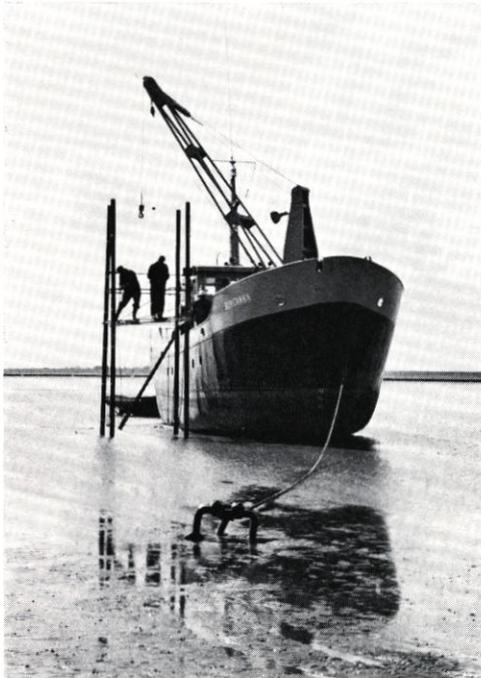
Abb. 13. Aufbau eines Wattdauerstrommessers
