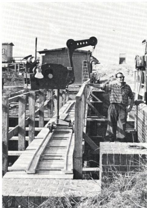
Abb. 16. Ablaufwinde während einer Sielzugmessung (Maadesiel)
