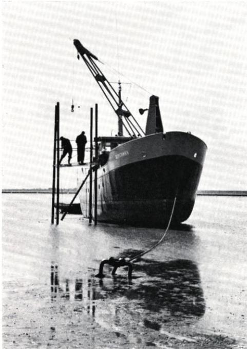
Abb. 13. Aufbau eines Wattdauerstrommessers
