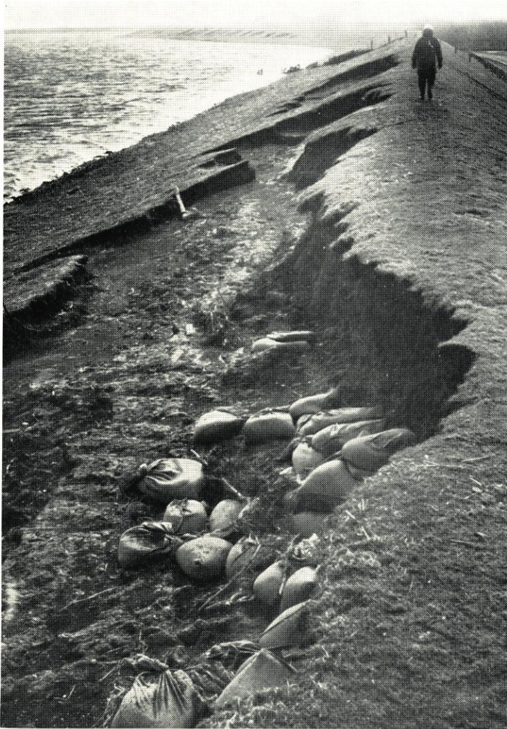
Abb. 1 Ausschläge auf der Deichböschung des Nor- derhever-Koogdeiches (Eiderstedt) 1962 etwa in Höhe des Sturmflut- wasserstandes. – Aus: RODLOFF (54, Abb. 2)
