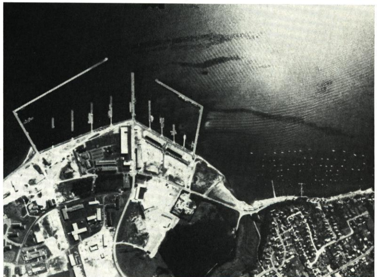
Abb. 3 Hafenanlage Eckern- förde – Luftbild
