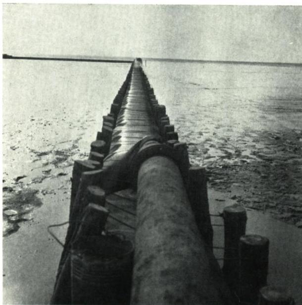
Abb. 7. Füllen eines Kunststoffgewebeschlaches als Lahnung
