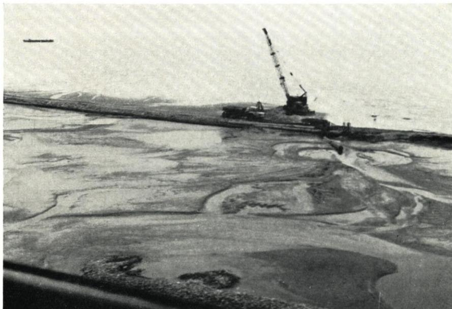
Abb. 2. Weit vor der Küstenlinie, durch tiefes Wasser, entsteht der neue Deich im südlichen Teil der Meldorfer Bucht. Zwischen Leitdämmen wird Spülboden eingebracht
