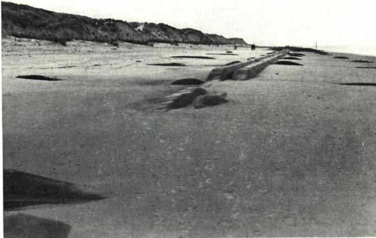
Abb. 3. Schlauchskelett auf dem Langeooger Nordweststrand durch Aufspülung und natürliche Sandzufuhren größtenteils eingedeckt (April 1973)
