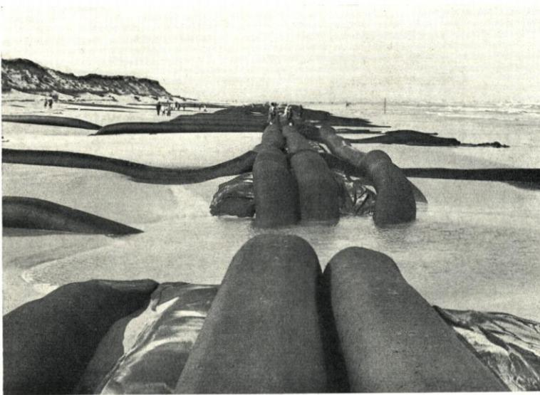
Abb. 5. Infolge Unterströmung abgesackte Teile der Längs- und Querwerke des Schlauchskeletts (April 1973)
