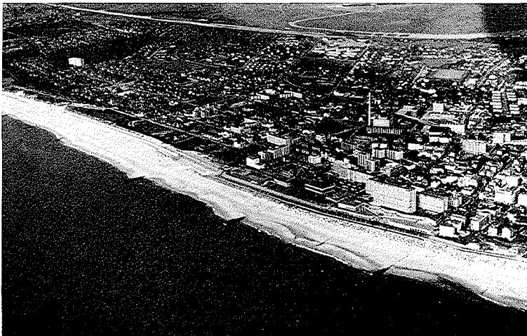
Abb. 1. Blick auf Westerland (Blickrichtung Ost). (Freigegeben unter Nr. SH-473/14 durch den Min. f. Wirtsch. u. Verkehr des Landes Schleswig-Holstein)
