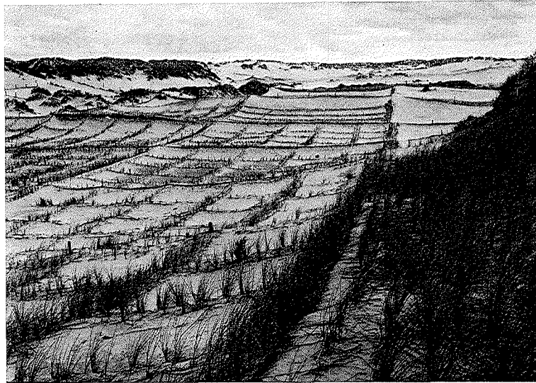
Abb. 11. Sicherung der Binnendünen. Trevira-Zäune als Quadratwerk, darin links Strandhafer netzartig, rechts an der Böschung Strandhafer flächenhaft gepflanzt
