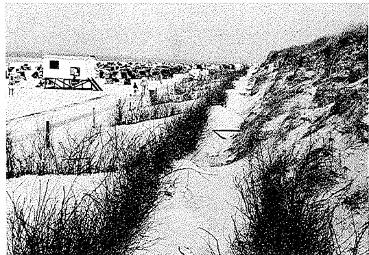
Abb. 8 Sandfangzäune am Schutzdünenfuß
