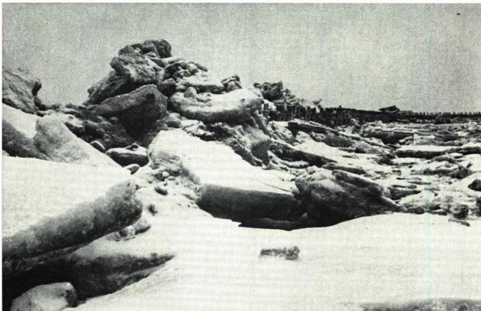
Abb. 4. Eispressung an einer Buhne
