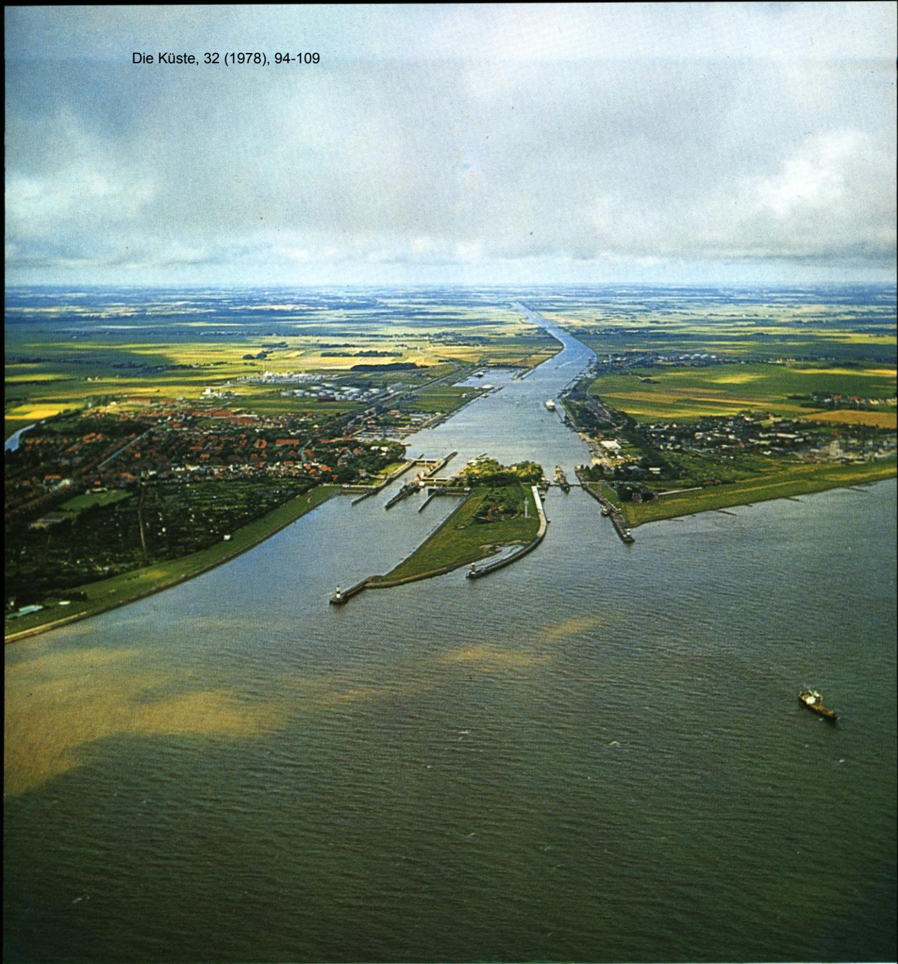
Tafel IX: Schleusen des Nord-Ostsee-Kanals. (Aufn. U. Muuß)
