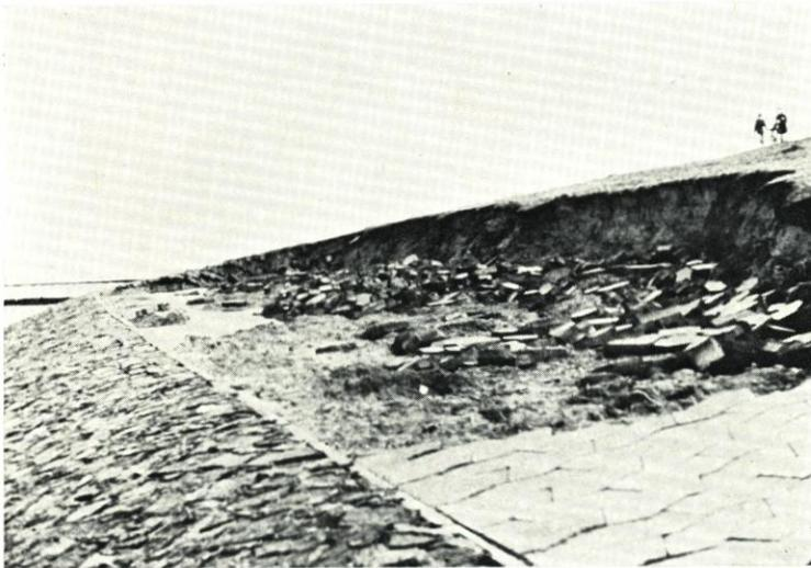
Abb. 11. Beschädigung des Betonsteindeckwerkes im Norden der Insel Nordstrand
