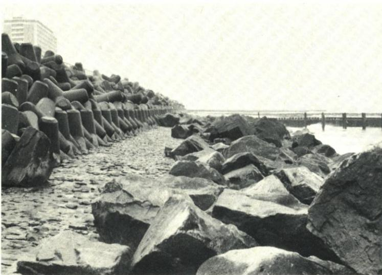
Abb. 10. Schutz der Ufermauer Westerland/Sylt durch Tetrapoden und eine Steinvorschüttung
