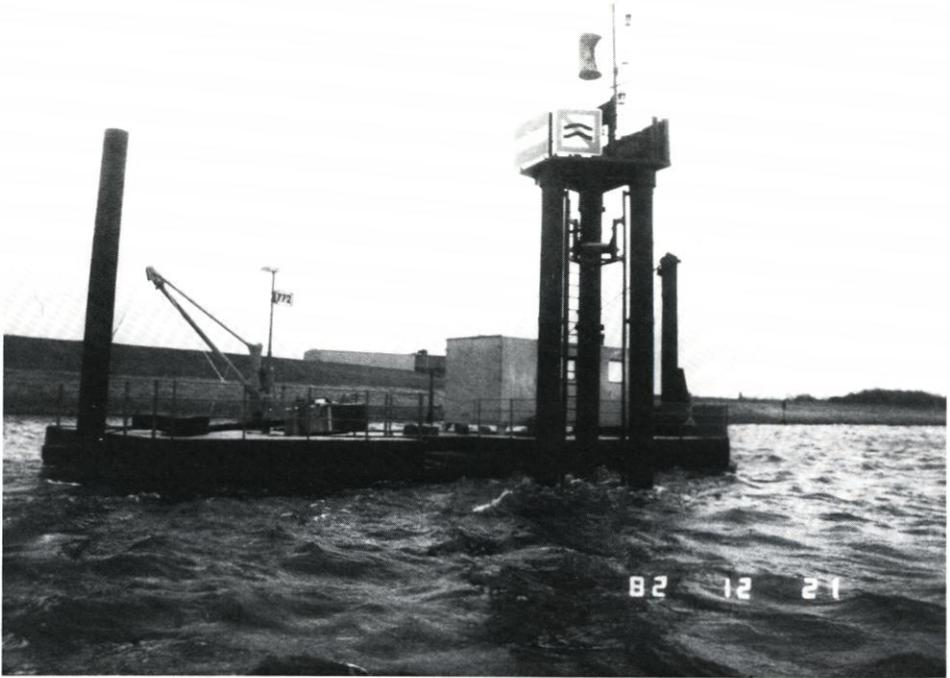
Abb. 2. Meßstation bei Oortkaten/Elbe mit dem Ponton und darauf dem Meßcontainer (Neumann phot.)
