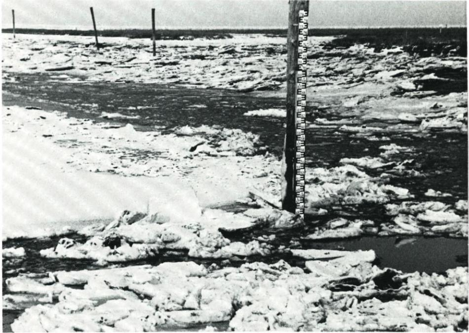
Abb. 2.10. Eisräumung während der Spülung im Hafengebiet – Lattenpegel für Spülsiel-Steuerpegel, Sensor unter der Wasseroberfläche –
