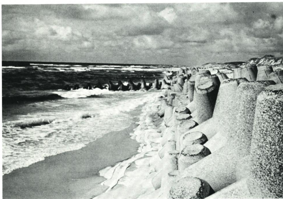
Abb. 8: Freilage der Tetrapoden-Auflage mit „Stummelbühne“ im Hintergrund nördlich des Querwerkes im Jahre 1977
