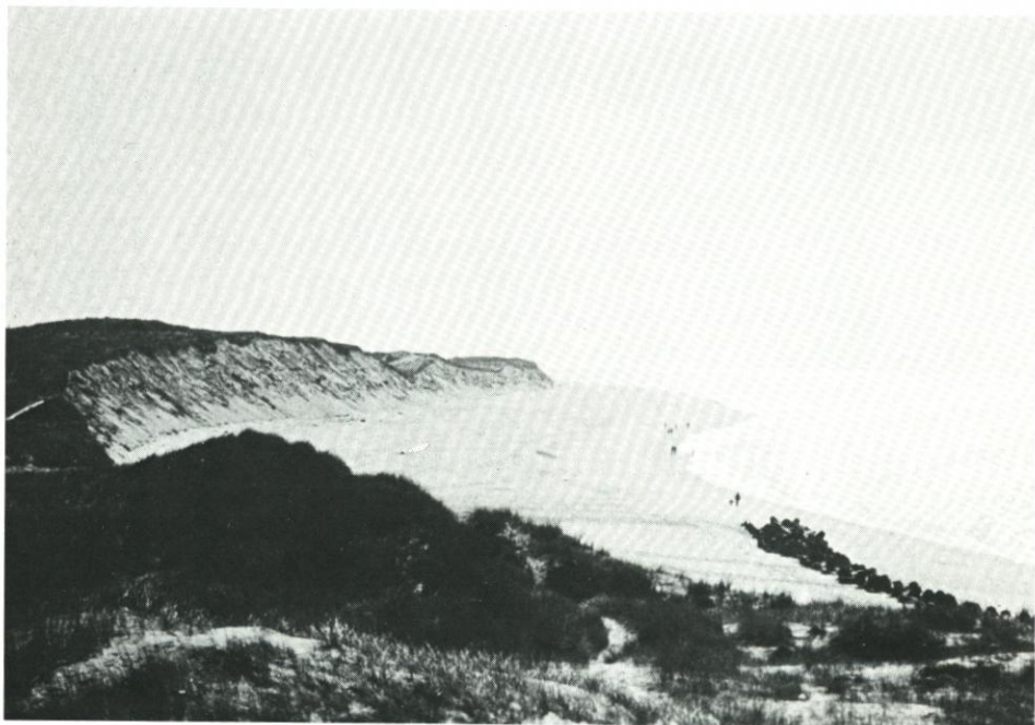
Abb. 7: Lee-Erosion südlich des Tetrapoden-Querwerkes und Bereich der Odde mit abgesackten Tetrapoden
