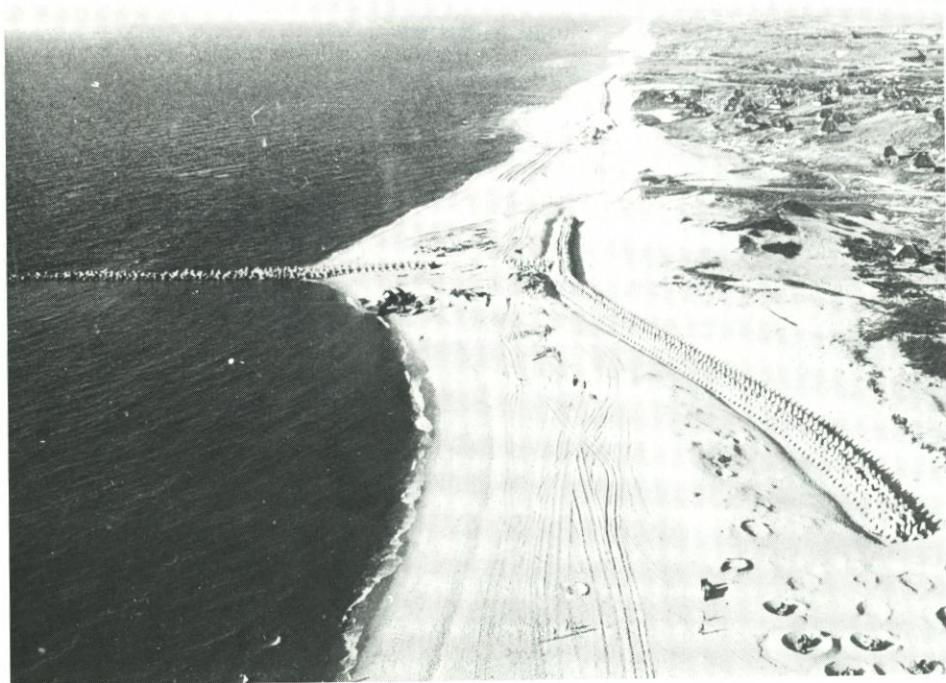
Abb. 3: Schutz der „Kersig-Siedlung“ durch ein Tetrapoden-Längswerk und Querwerk (Blickrichtung Nord z. Z. der Erstellung)
