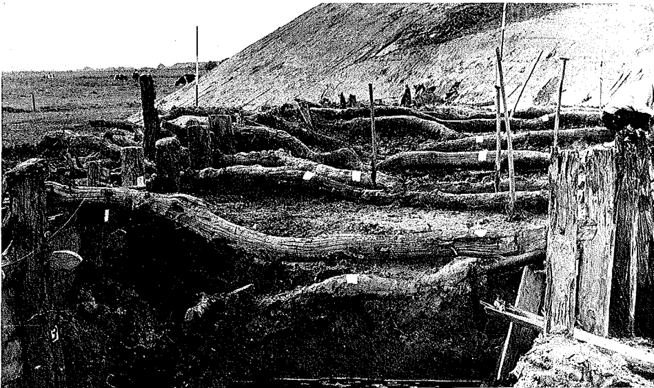
Abb. 10.23. Nach der dritten Aufgrabungsphase (Hauptgrabung) beansprucht der Doppelstackdeich am „Halben Mond“ den Hauptanteil von der Grundfläche der Baugrube. Der Doppelstackdeich liegt hier in breiter Front vor der sieben Meter hohen Böschung der Seedeichaufgrabung Südermarsch-Lundenberg. Rechts oben der aufgegrabene Deichkörper
