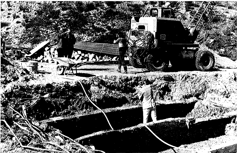
Abb. 9.5. Bevor beide Kammern des Nüstersiels geöffnet werden konnten, mußte die darüber liegende Kleierde von etwa 1 m Stärke abgebaut werden
