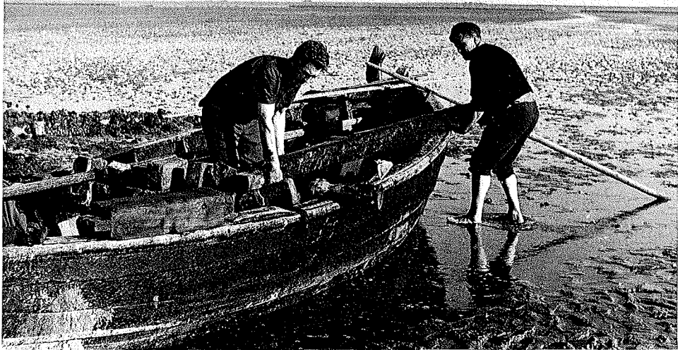
Abb. 5.9. Die aus dem gezimmerten Verband von Hand gelösten eichenen Fachwerkgebände wurden im Arbeitsboot des Marschenbauamtes verladen und mit dem Flutstrom an die hohe Vorlandkante gerudert
