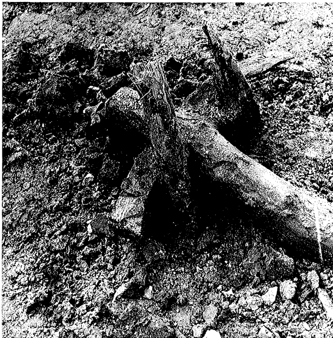
Abb. 10.21 Stackdeichanker mit sichelförmigem Splint. Montage durch zwei Funktionshölzer nur auf „Zug“
