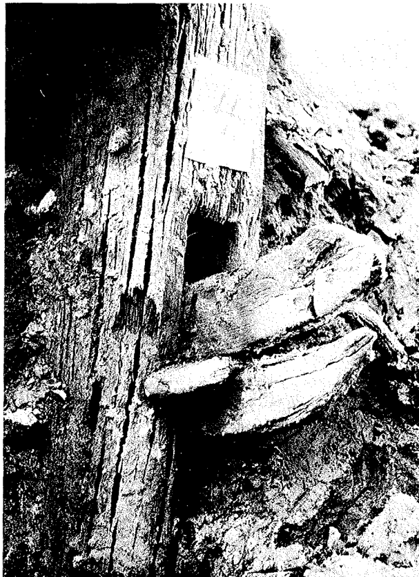
Abb. 10.15. Obwohl vor Jahrhunderten aus dem Kernholz der Waldeichen gezimmert, unterliegen die Stackdeichelemente (Abb. 10.16) nach der Öffnung ihrer jahrhundertlangen Einlagerung in dem tonigen und dauerfeuchten Substrat „Klei“ sehr schnell der Schrumpfung (hier Stammeiche mit der Grabungsnummer 4)
