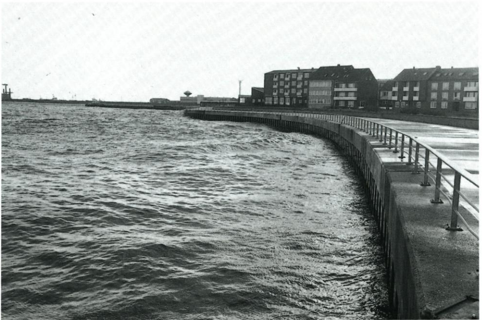
Abb. 10: Das sanierte Promenaden-Bohlwerk nach der Fertigstellung 1987
