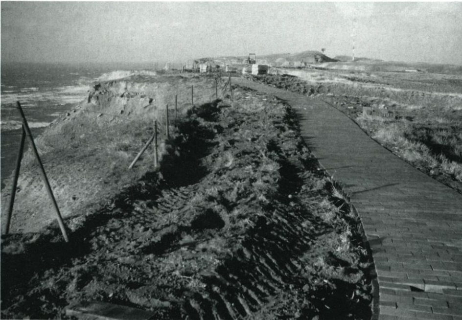
Abb. 15: Klippenrandweg, Bauzustand – Januar 1990 –
