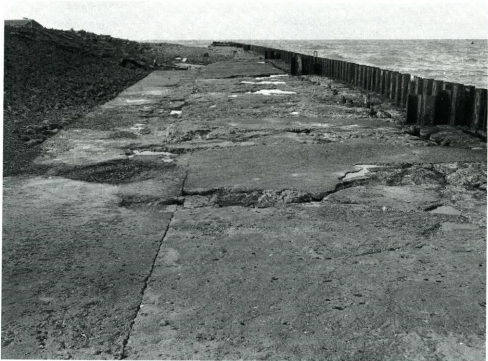
Abb. 3: Schadhafes Nordost-Bohlwerk Mitte der 70er Jahre (Insel-Foto Cohrs)
