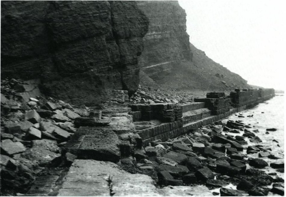
Abb. 6: Zerstörte Südwest-Schutzmauer, 1945
