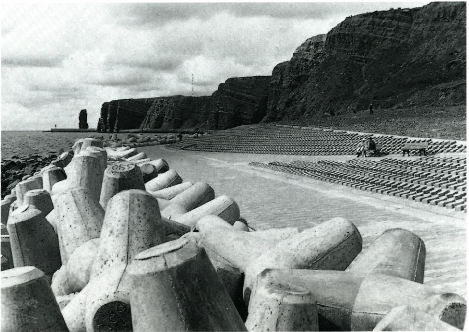
Abb. 12: Uferdeckwerk am Kringsel, 1965
