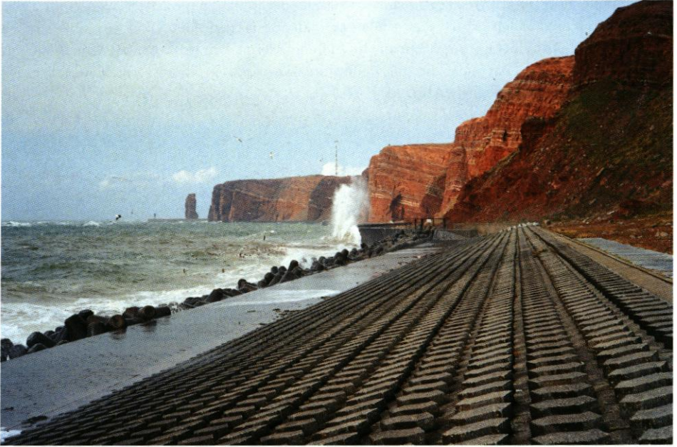
Abb. 14: Uferdeckwerk am Kringsel Blickrichtung Norden, 1987
