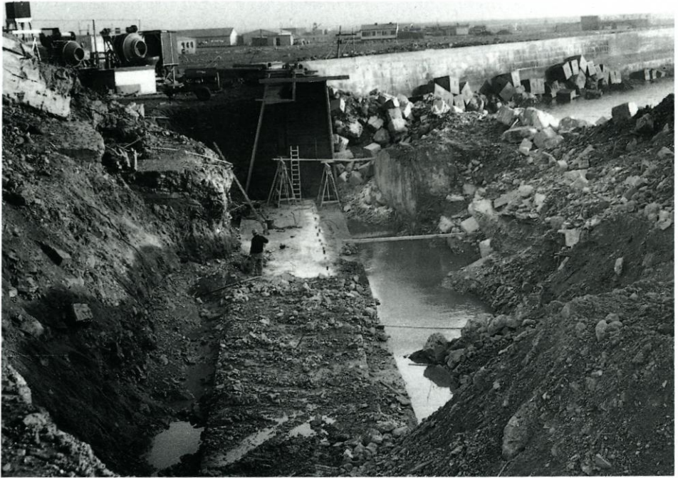
Abb. 8: Fundament der alten Südwest-Schutzmauer bei der Westmauer
